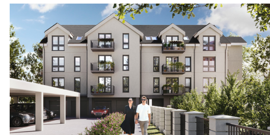
Widok na budynek
